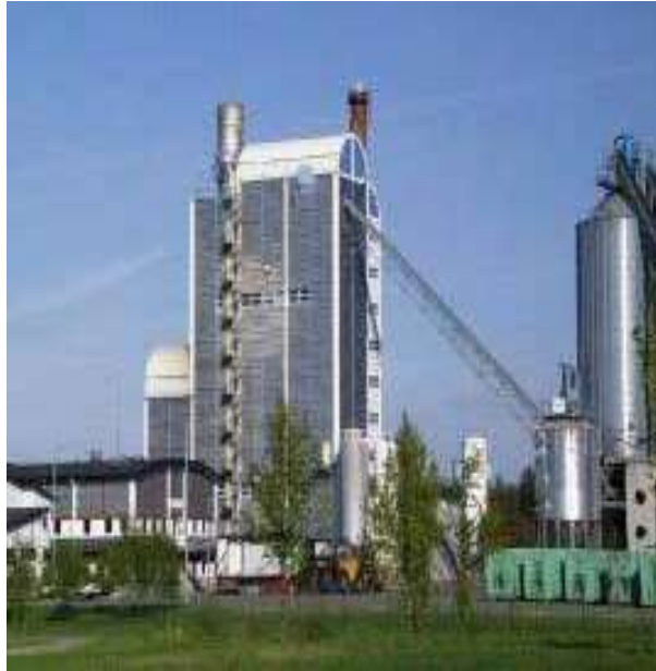
Система генерации в Vaxjo Varnato 6Мвт электричества 9МВт тепла из сухой биомассы
